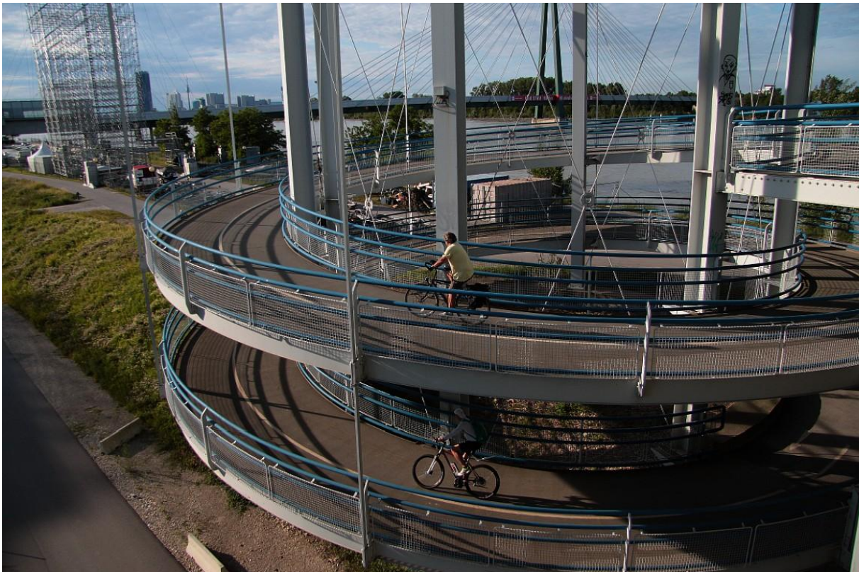
Fot. 13. Pochylnia ślimakowa prowadząca z brzegu Dunaju na drogę dla rowerów zlokalizowaną w dolnym poziomie mostu Praterbrücke. Widoczna prawidłowa orientacja pochylni: w lewo w dół, zapewniająca większy promień łuku rowerzystom jadącym z większą szybkością w dół i minimalizująca ryzyko kolizji. Zwraca uwagę wysoko umieszczona barieroporecz. Wiedeń, Austria.
